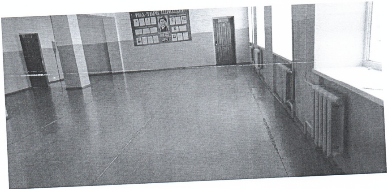
Фото 10, 10а. Вестибюль 3й этаж.
